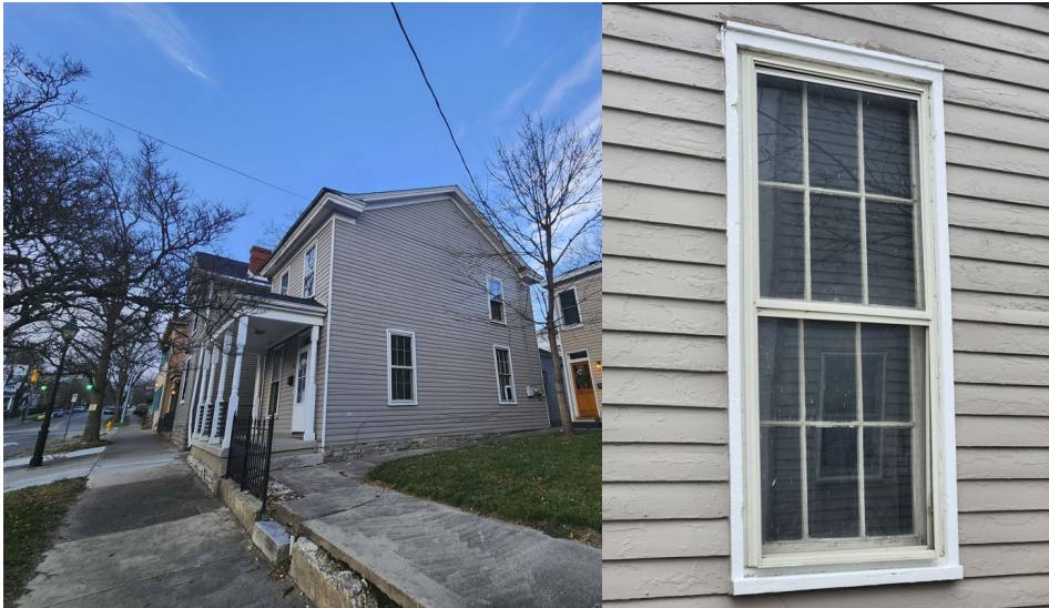
Right Façade Windows
