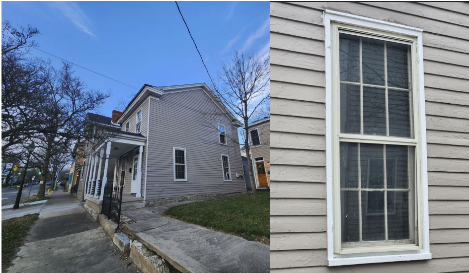
Right Façade Windows
