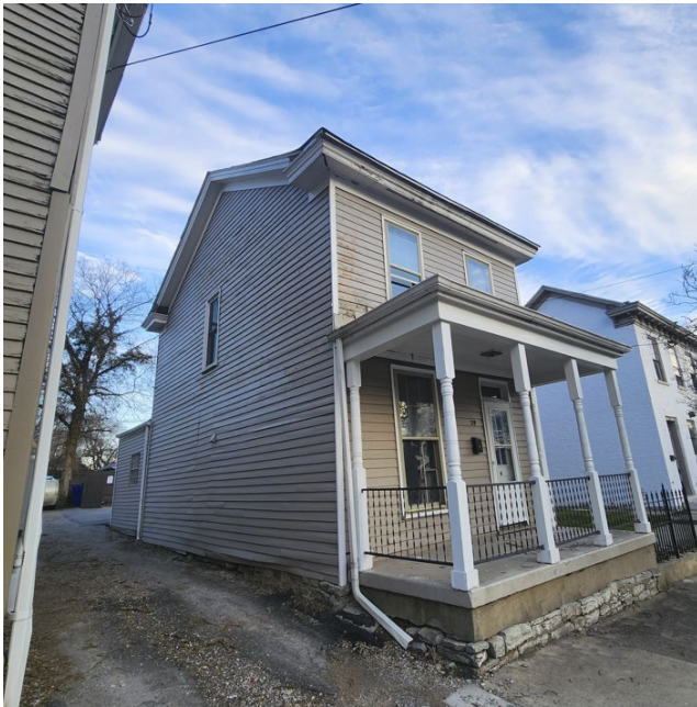
Left Façade Windows
